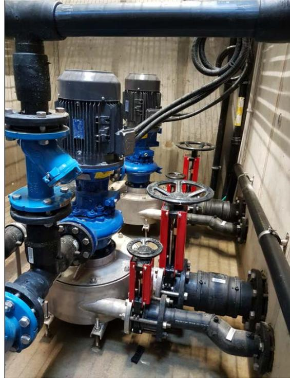
La nouvelle station de pompage comprend une cuve de réception des eaux usées et un local, dit sec, abritant les pompes, le tableau de commande et l'armoire électrique ceci conformément aux normes de sécurité du travail en vigueur.
